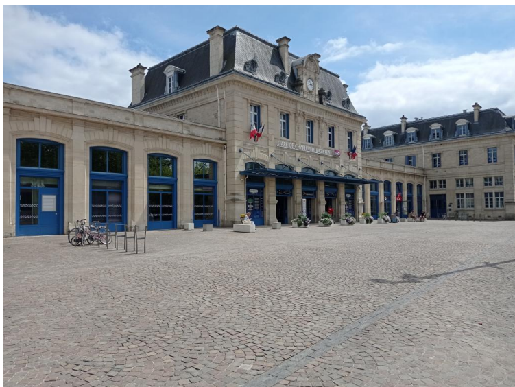
Entrée par le bâtiment principal, de plain-pied
